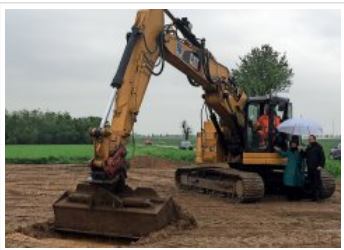
Die Erschließungsarbeiten für die ersten 24 von geplant rund 270 neuen Eigenheimen an der Rehbacher Straße wurden in dieser Woche offiziell gestartet. Foto: Jens Rometsch
